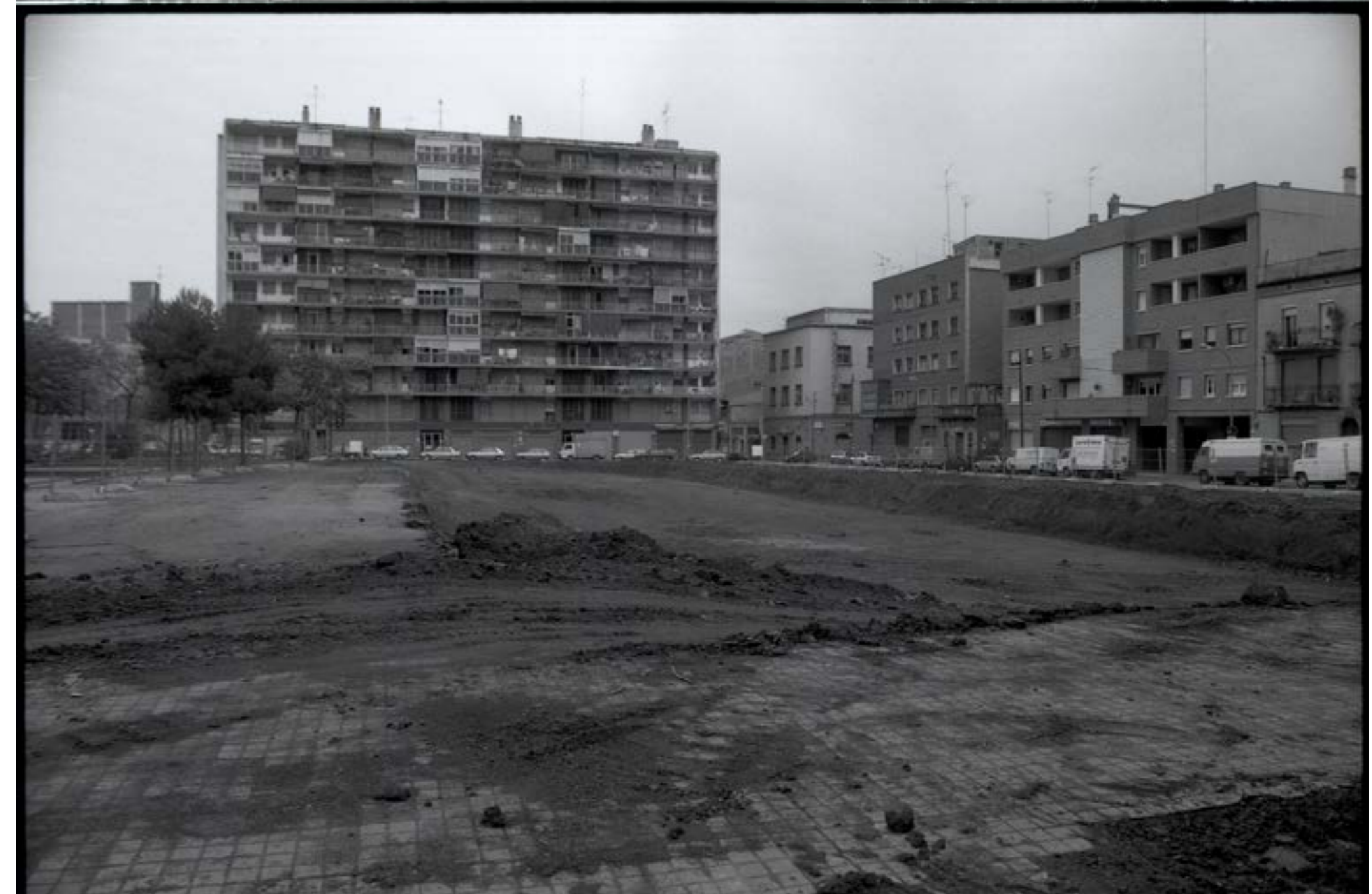
Abril 1994 • Construcció parking plaça de les Rates
